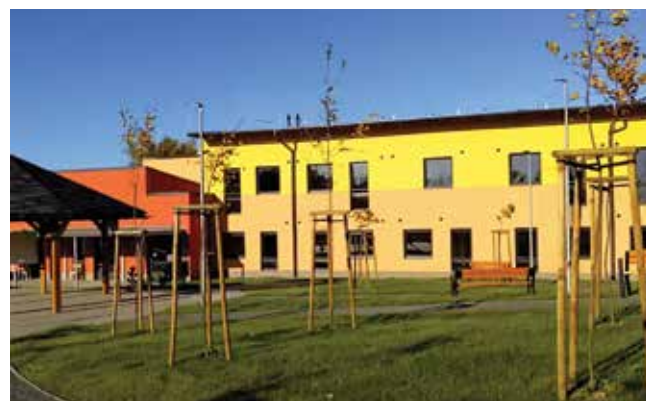
Domov pro seniory „U kaple“ v Dětmarovicích
